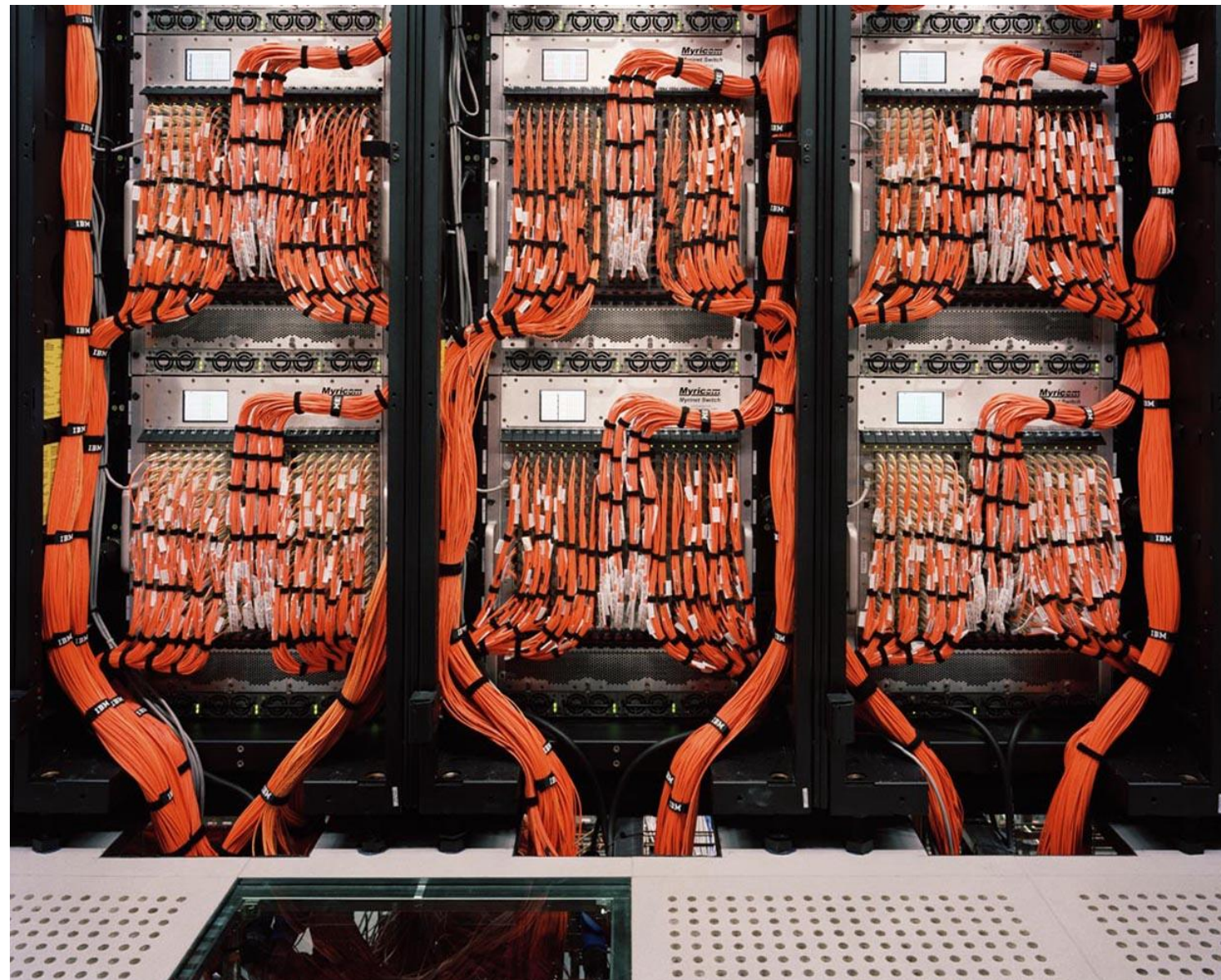
3 racks con elementos de interconexión de Myrinet
